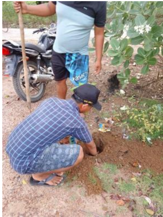
Gambar 2. Pembuatan Lubang Biopori
