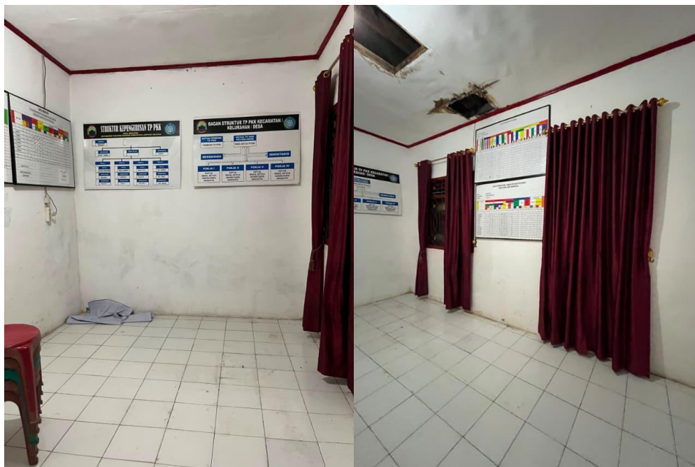
Gambar 1. Kondisi Perpustakaan Desa Srikaton sebelum dilakukan penataan
